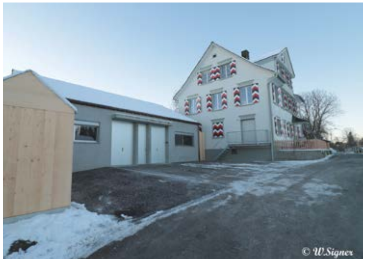
Ökonomiegebäude und Kirchlihaus
